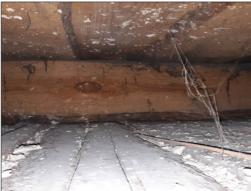
Obr. č. 9 - Sonda do stropu, detailní pohled na dřevěný trám. Dřevo trámů i fošen je suché, zcela zachovalé.
