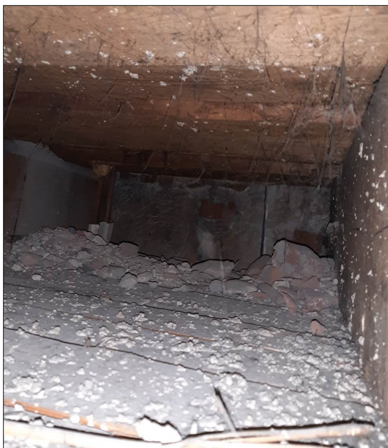
Obr. č. 10 - Sonda do stropu, detailní ve směru uložení trámů. Dřevo trámů i fošen je suché, zcela zachovalé.
