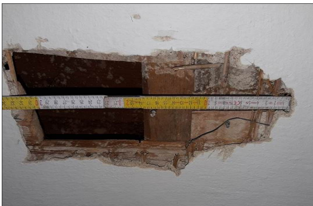
Obr. č. 8 – Sonda do stropu, detailní pohled.
